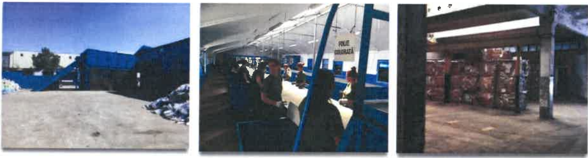
Figura 2-26: Stație de sortare S.C. URBAN S.A.
